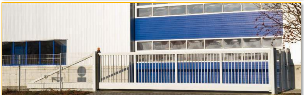
Zaun- und Toranlage Strako GmbH
