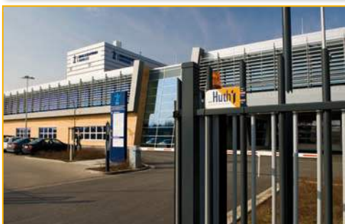
Zaun- und Toranlage des Druckzentrums Nordsee GmbH
