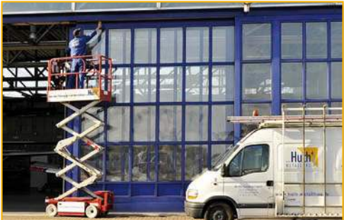
Wartungsarbeiten an einem Hangartor
