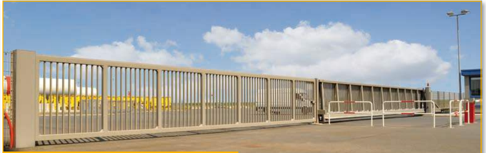
Tor- und Zaunanlage von über 1000 m Länge
